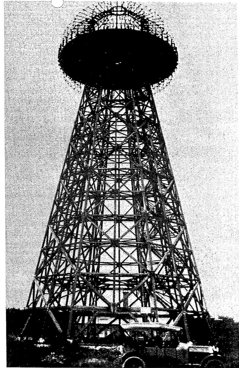
Der Wardenclyffe Tower, zwischen 1901 und 1903 für Radiosendungen und drahtlose Energieübertragungen über den Atlantik gebaut
